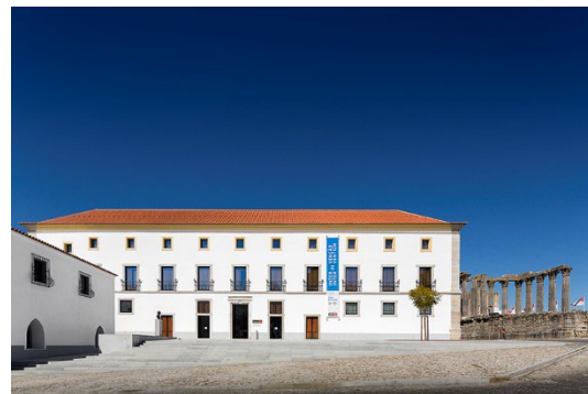
Escadas e patamar de acesso
